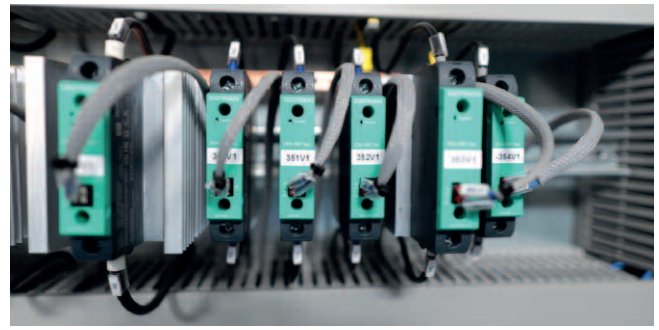
Die einphasigen Halbleiterrelais der Serie GRS-H mit integrierter Diagnose stellen eine ideale Lösung für Kunst- stoffextrusionsmaschinen dar, da sie Lastunterbrechungen und mögliche Störungen des Regelkreises schnell erkennen (Bild: Gefran / Bausano)
